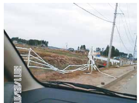
南萱浜地区壊滅
